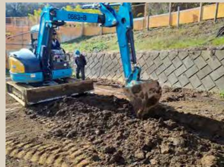
機械による表土掘削
