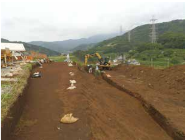
7区残地③ 作業風景
