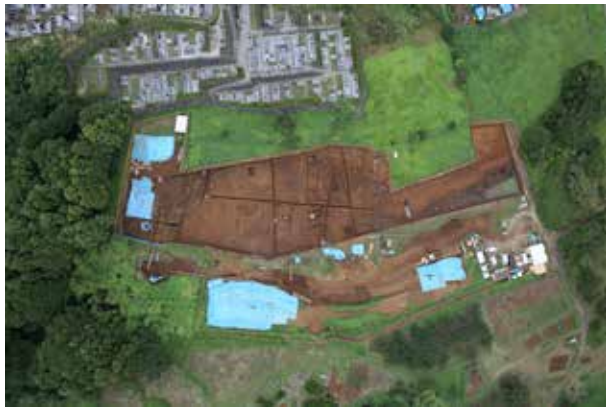
1区北中世面全景
