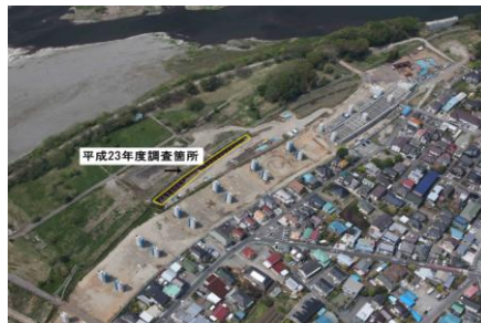
▲ 2. 平成23年度調査箇所(南東から撮影)
